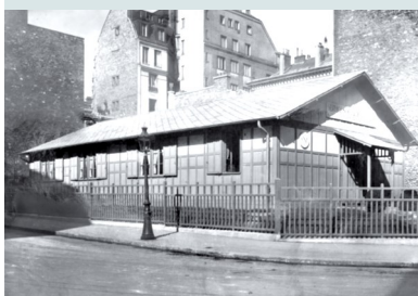
Les locaux provisoires de la rue Surcouf
